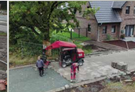
Herstellung von Pflasterflächen
